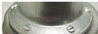
Después de la colocación
